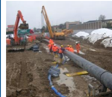
Pullback DN650(24") pipe string
