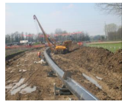
Pullback DN650(24") pipe string
